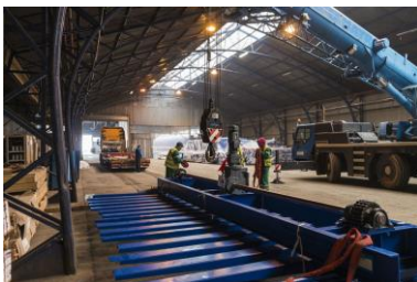
Elemente der neuen Presse werden vom Lkw abgeladen (Bildnachweis: Attila Balázs/INTERSPAN Faipari Kft.)
