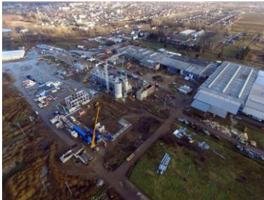
Bildmitte: Energieanlage und Produktionshalle, Hintergrund: Vásárosnamény (Bildnachweis: Árpád Hegedüs)
